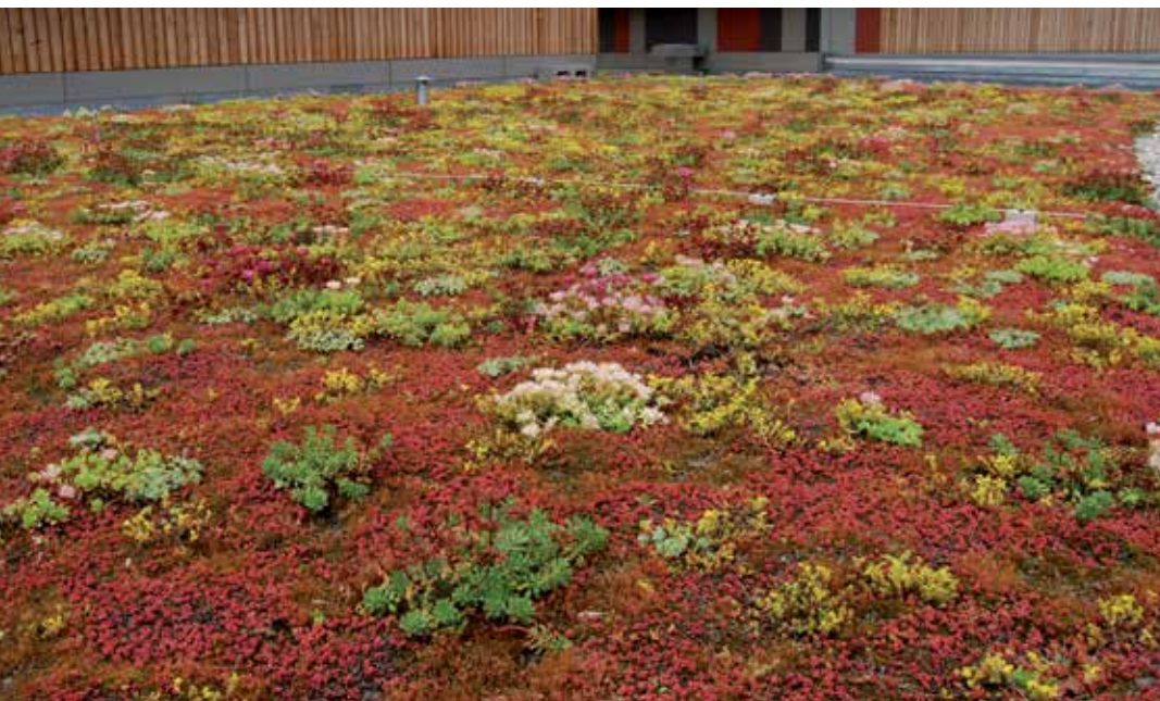
Moos kommt auf, das Sedum ist wegen Nährstoffmangel rötlich gefärbt. Hier muss gedüngt werden.
