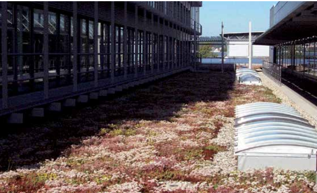
Foto 1 Licht + Schatten Verschattete Extensivbegrünungen neigen zur Vermoosung
