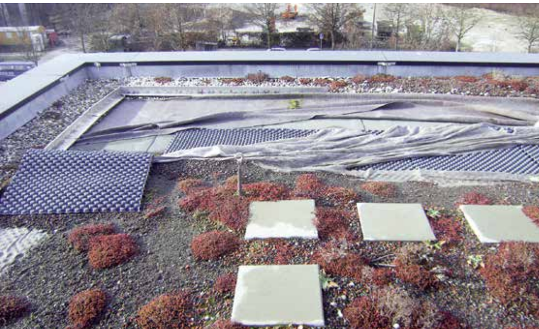
Foto 2 Windverwehung Windverwehung bei einer nicht geschlossenen Vegetationsdecke
