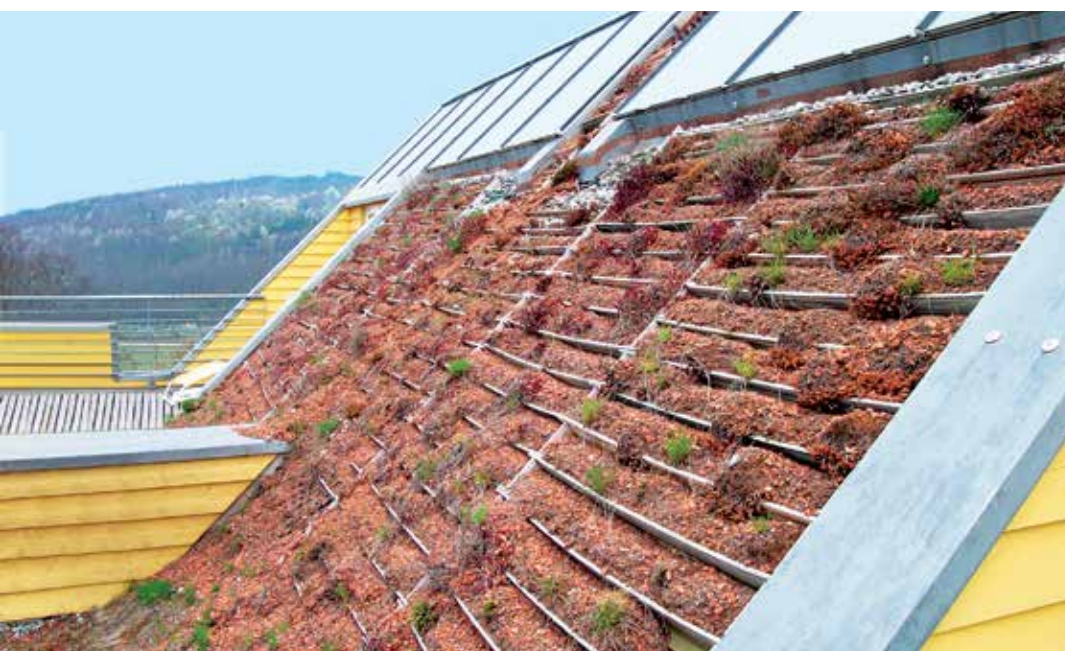
Abb. 3: Lückenhafter Bewuchs Grund: ungeeignetes Substrat, Staudenpflanzung statt Vegetationsmatten, mangelnde Pflege.
