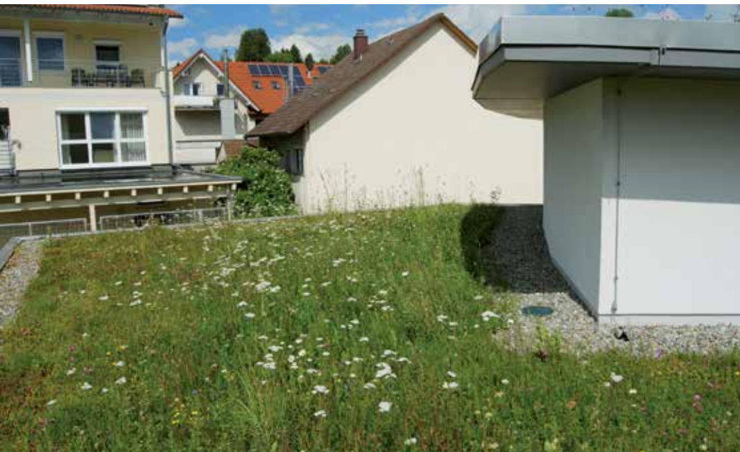
Foto 2 Regenschatten Kiesstreifen bei Regenschatten durch überstehende Dächer
