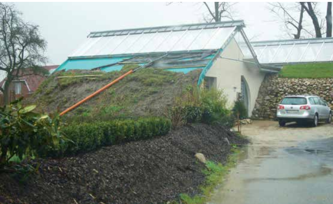
Abb. 2: Ebenso abgerutscht Schubswellen aus Holz und Entwässerungsprobleme.
