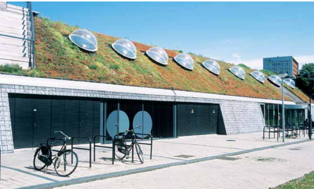
Vor allem Steildachbegrünungen bedürfen einer guten Planung und Ausführung
